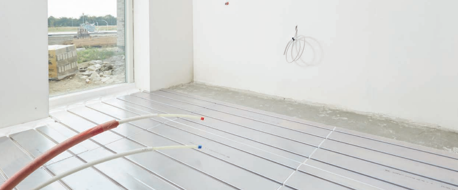
Deler av det 200 m 2 store huset er lagt med Roth Compactsystem, og resten er med nedstøpte rør i betong.
