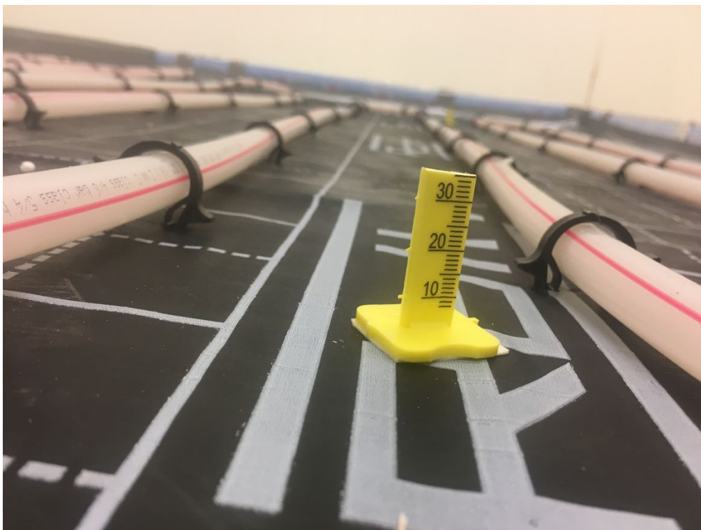
Foto 9: Støpedybde 35 mm for objekt med senteravstand 150 mm
