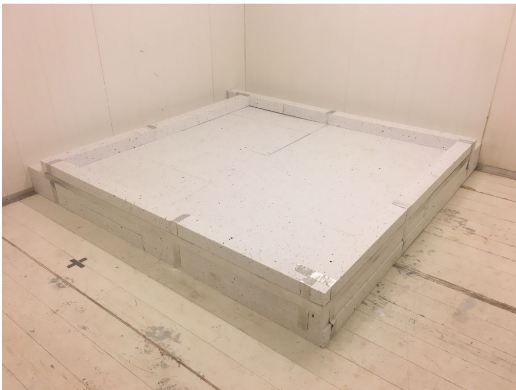
Foto 3: Støpekar av EPS
