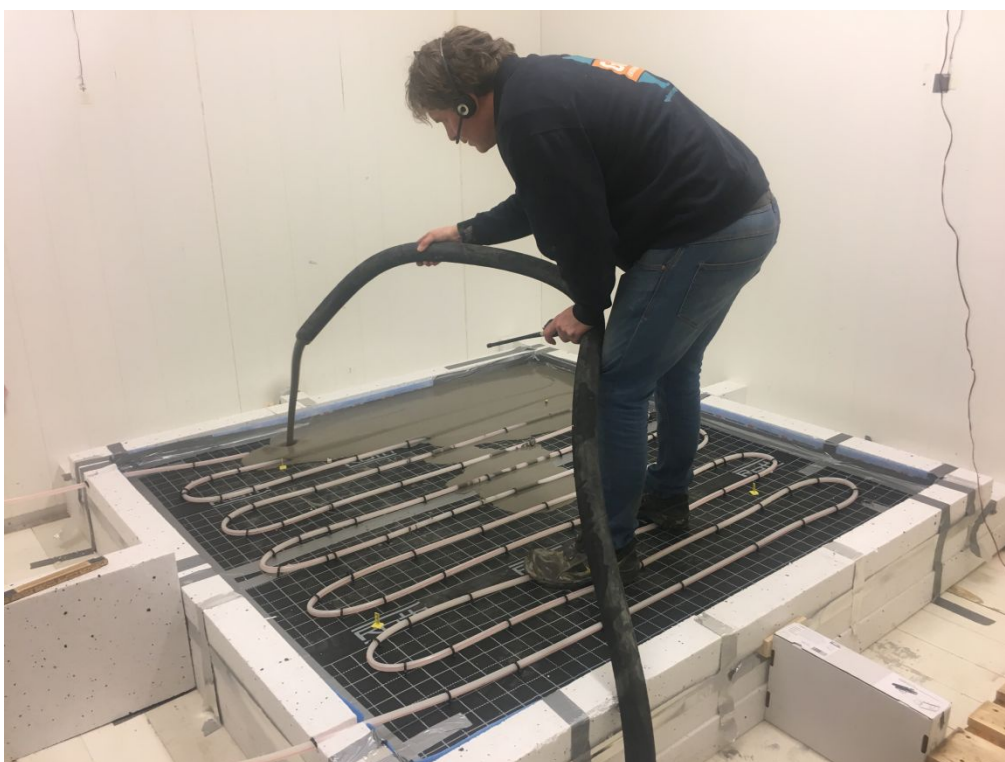
Foto 10: Utstøping av golv med senteravstand 150 mm
