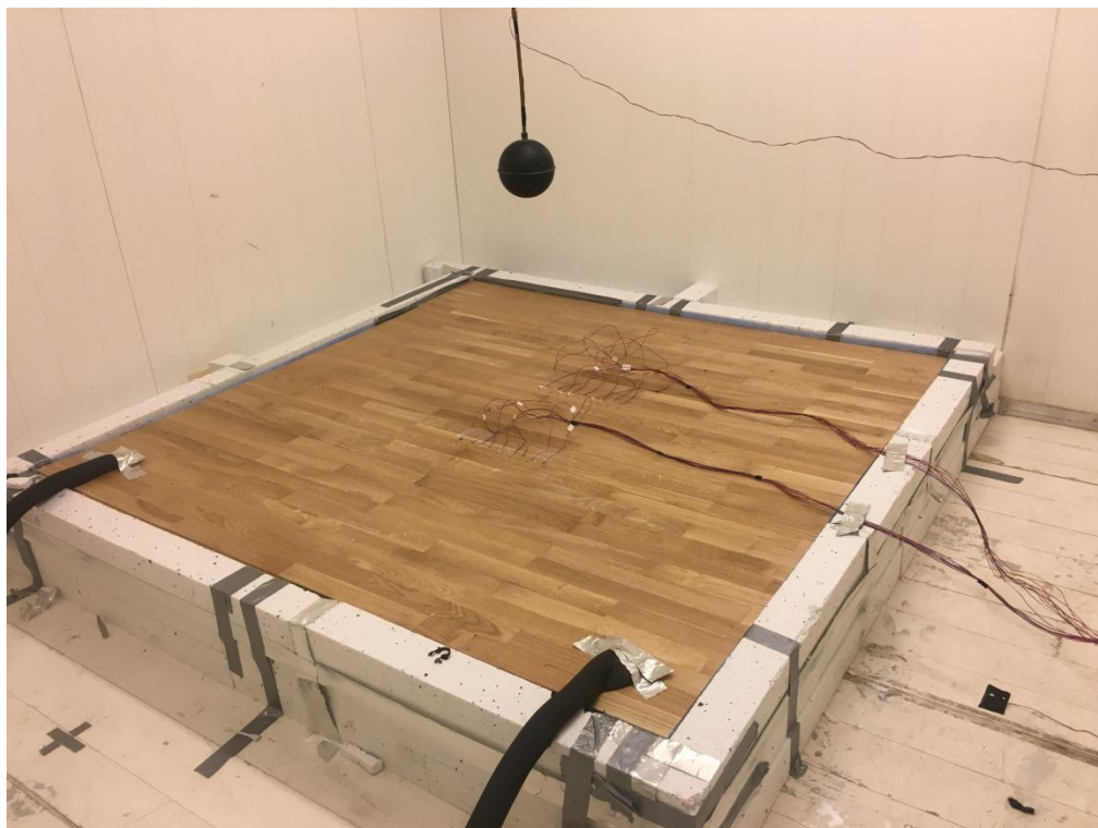
Foto 17: ferdig gulv med parkett og temperaturfølere
