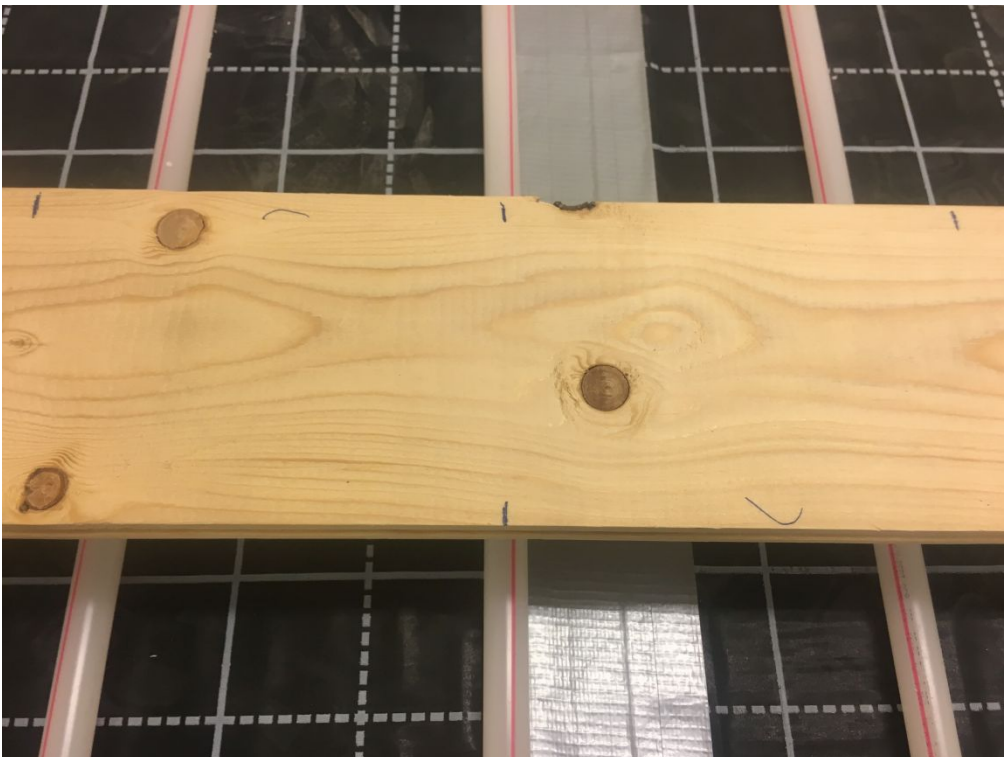
Foto 8: En planke ble brukt til å markere hvor senterrøret var plassert
