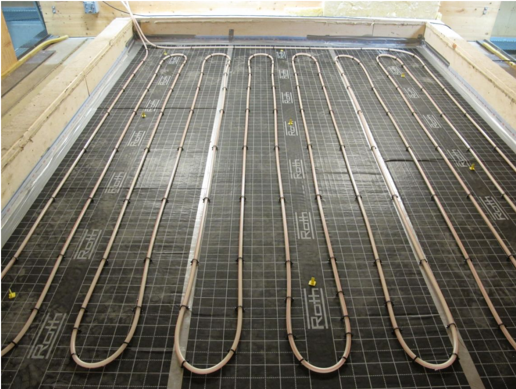
Foto 5: Vannrør festet med festeklips med c/c 200 mm
