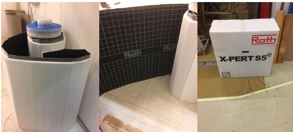
Foto 1: Trinnlydplate og vannrør
