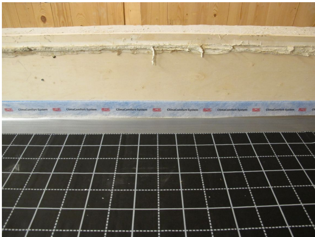
Foto 3: Avslutning mot omramming (sett fra siden)
