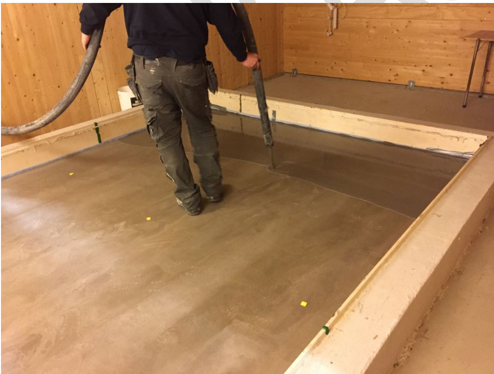
Foto 6: Tynnavretting på 35 mm avrettingsmasse med ytterligere 6 mm
