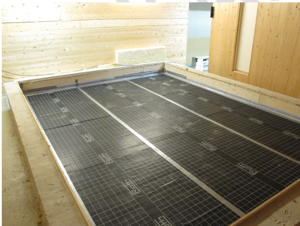
Foto 4: Ferdig lagt trinnlydplater
