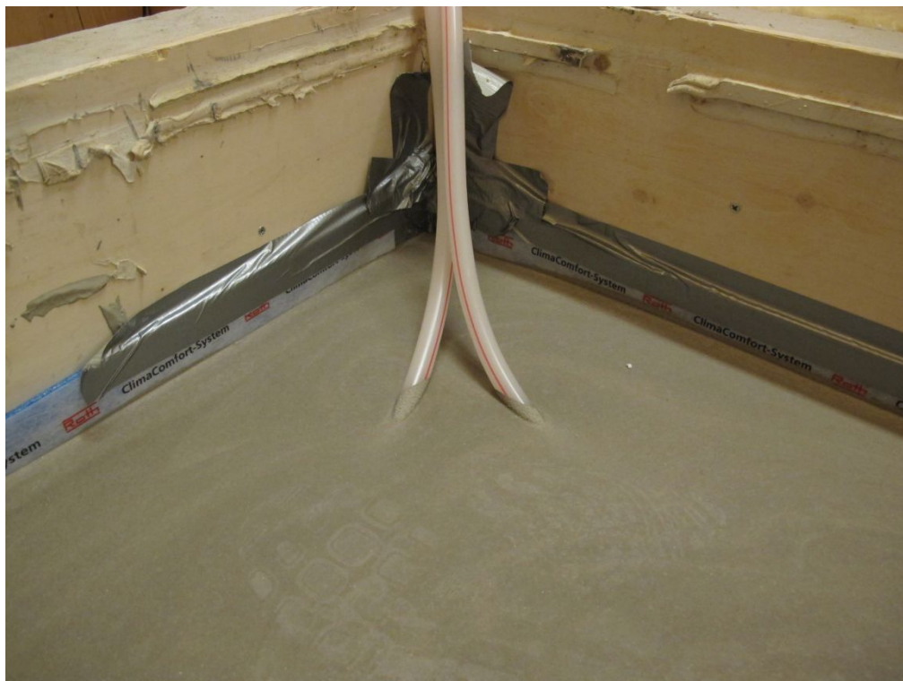
Foto 7: Vannrør er fylt med vann og ført opp i et hjørne
