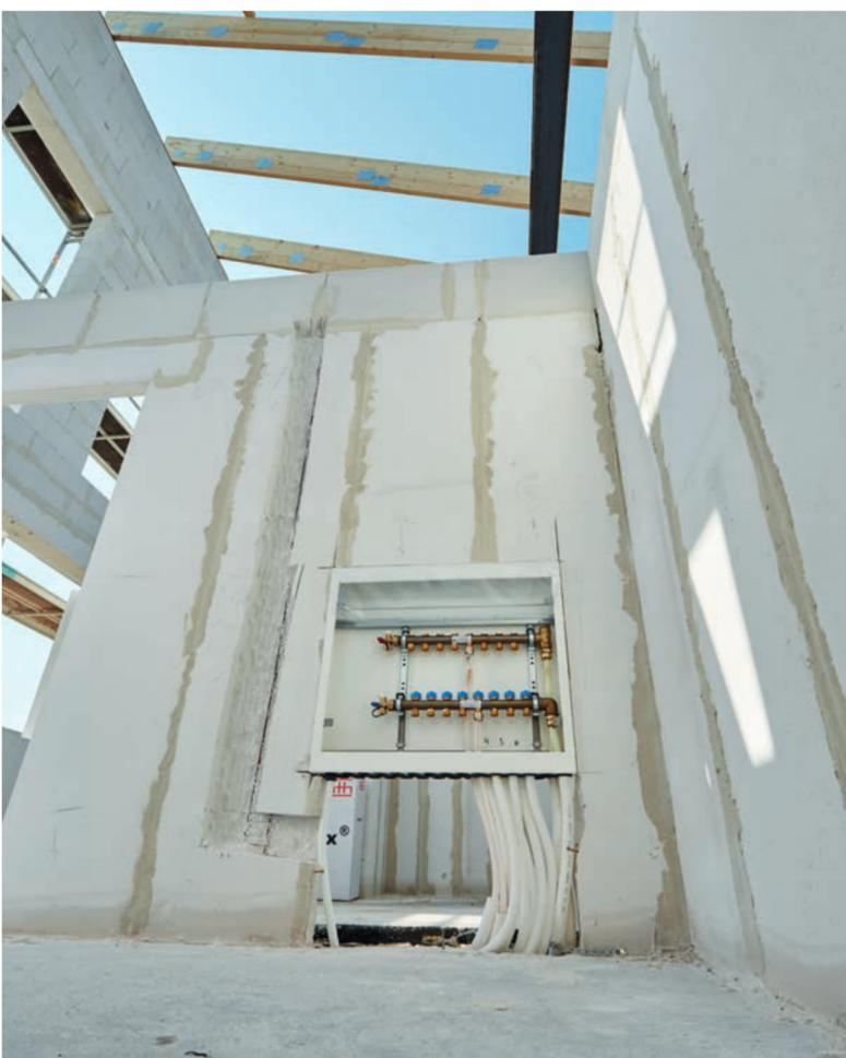
De 2 Touchline kontrollenheter er koblet sammen trådløst og er tilkoblet husets router. Slik kan eieren overvåke og endre temperaturer via mobil eller tablet.
