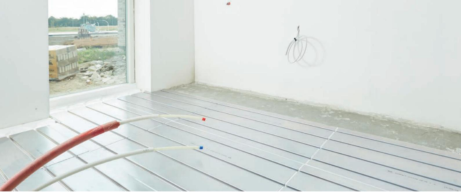
Deler av det 200 m<sup>2</sup> store huset er lagt med Roth Compactsystem, og resten er med nedstøpte rør i betong.
