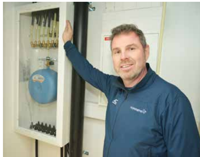
Lars Ketil Aune, Roths distriktsleder i Midt-Norge viser frem fordeleskapet slik de er montert i alle husene/leilighetene på Jessheim.
