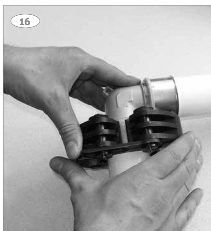
13: Ved pressing av 40, 50 og 63 mm brukes Roth innsatser.
