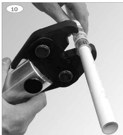
10: Plasser pressbakken (til 16 - 32 mm) på pressringen mellom plastdelen og pressringens krage.
