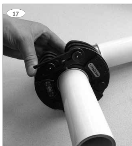
14: Plasser pressinnsatsen på PressCheck® fittingsen.
